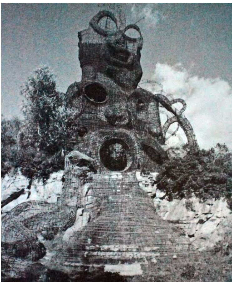
Imagen 27 - El Mago y la Sacerdotisa: La estructura fabricada de armaduras de hierro soldado y malla de alambre para sujetar el cemento.
